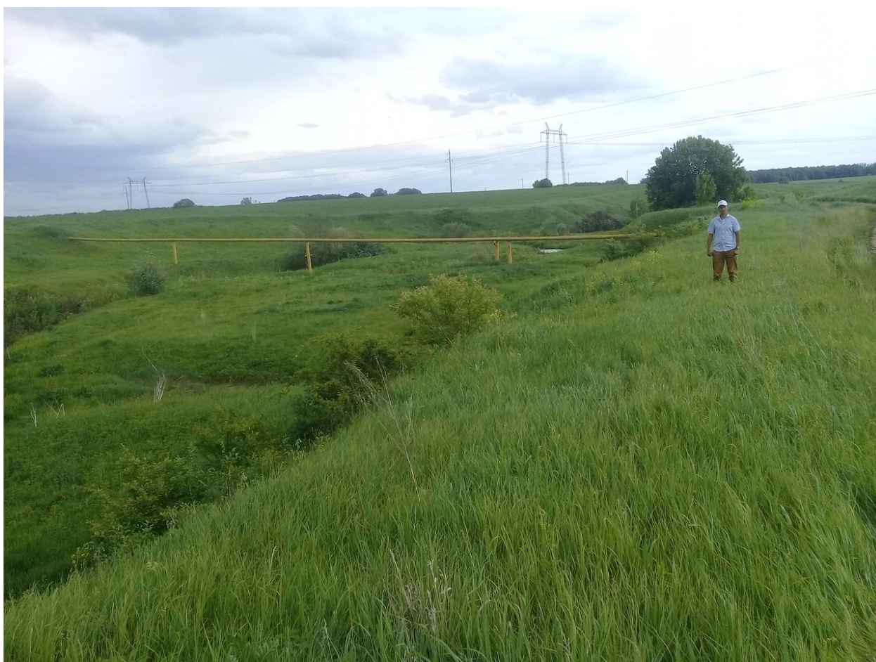
Рисунок 22 –Газопровод на землях хозяйства ООО «Бирюли»
