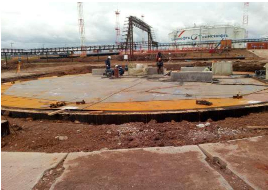
Рисунок 11- Монтаж окрайки днища в проектное положение
