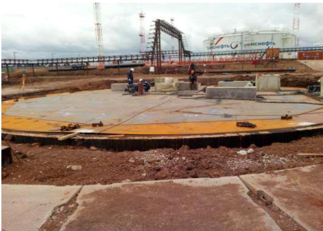
Рисунок 8- Монтаж окрайки днища резервуара вертикального стального объемом 3000м<sup>3</sup> в проектное положение
