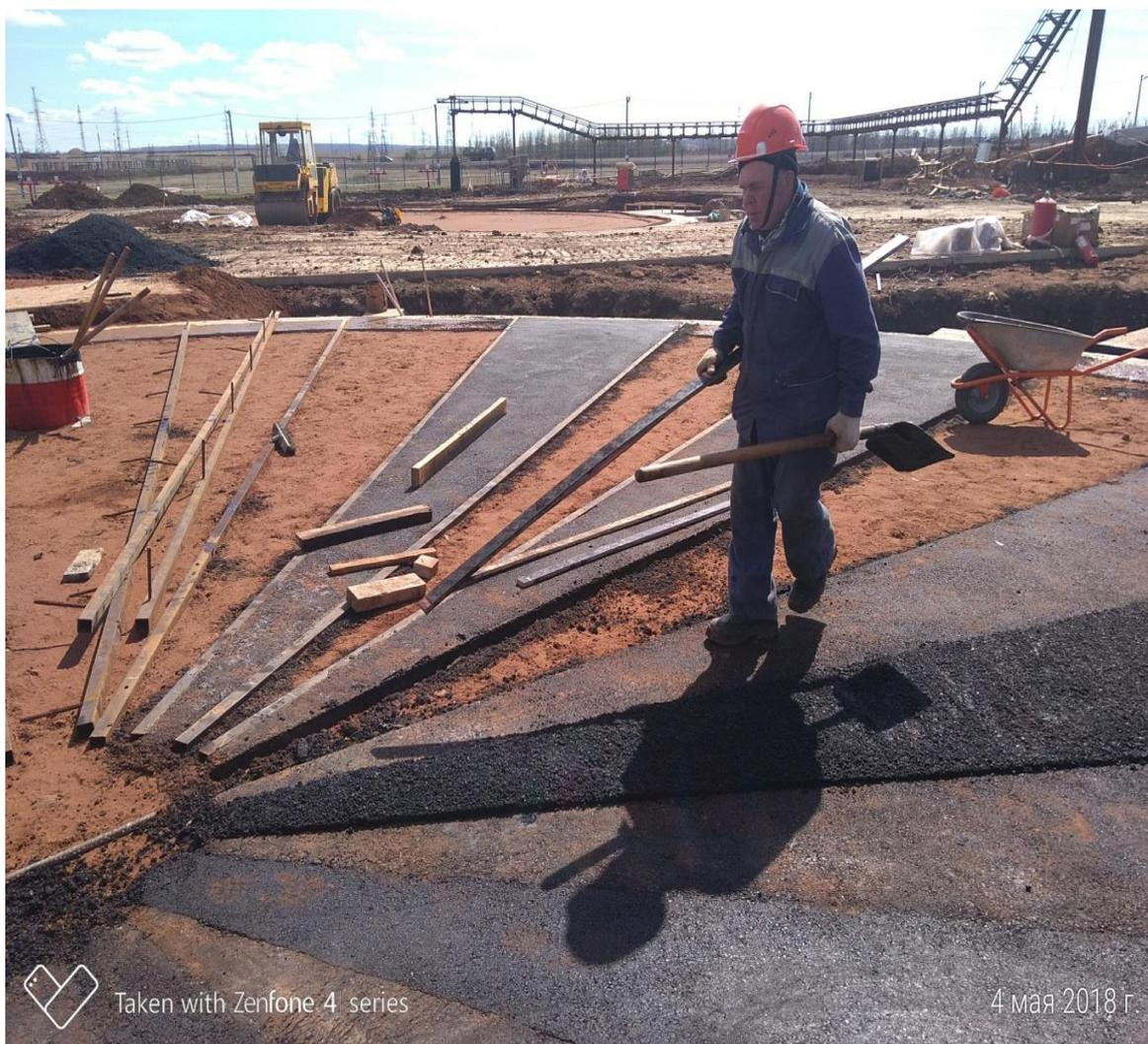
Рисунок 7- Устройство гидрофобного слоя РВС-3000№1
