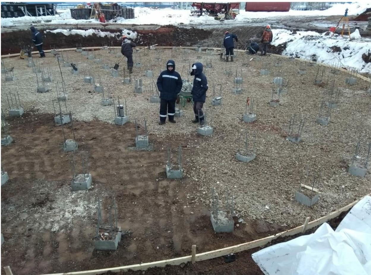
Рисунок 5-Планировка основания под РВС-3000№1, устройство опалубки бетонной подготовки под кольцевой фундамент.
