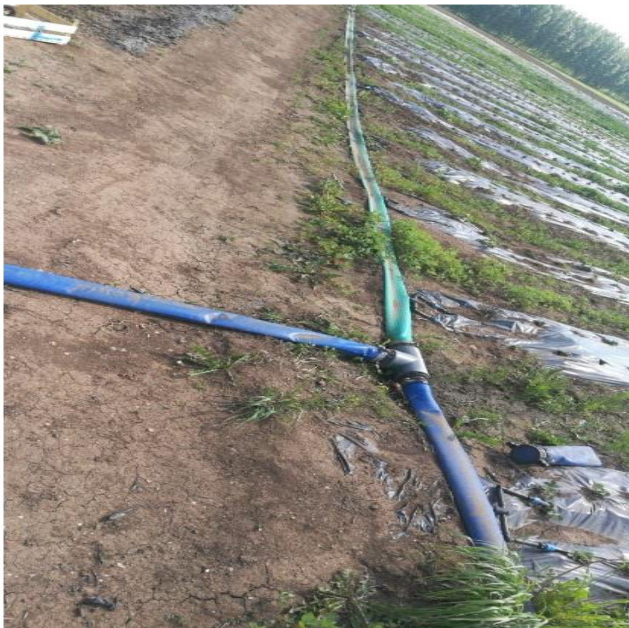
Фото 5. Трубопровод доставляющая воду к грядкам
