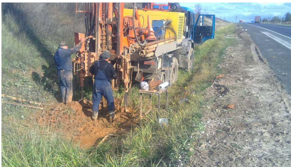
Фото 5. Скважина № 52В ПК 64+00
