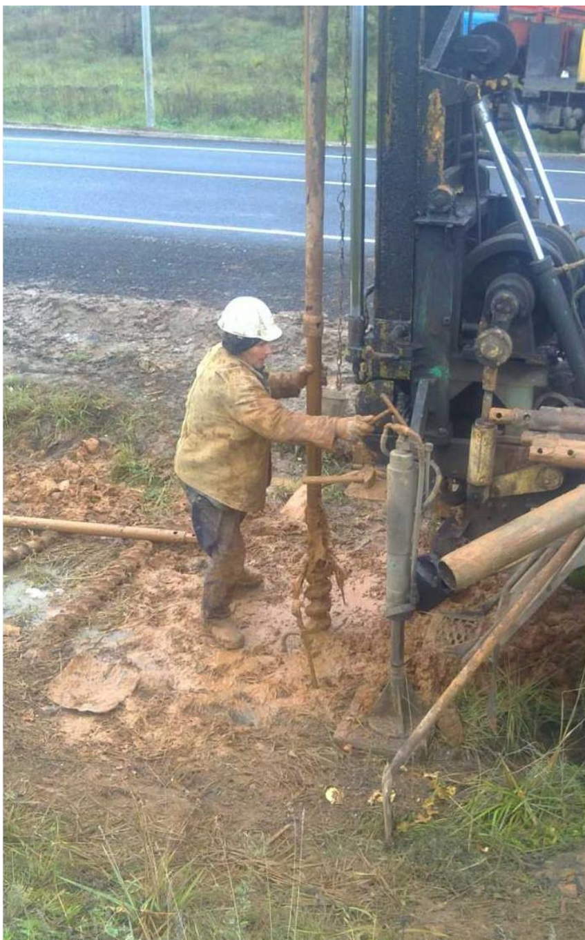
Фото 6. Скважина № 58В ПК 66+05
