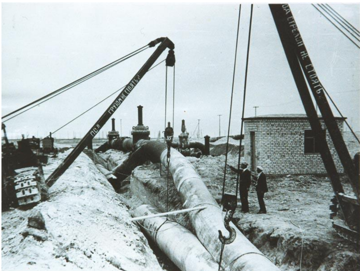
Рисунок 3. Прокладка первых трубопроводов
