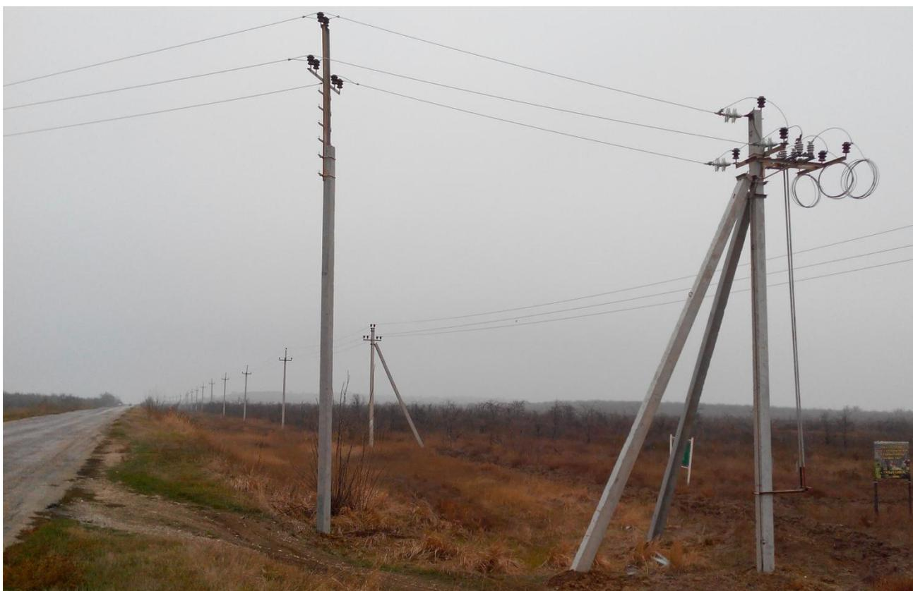
Рисунок 4 – Опоры воздушной линии электропередачи 10 кВ
