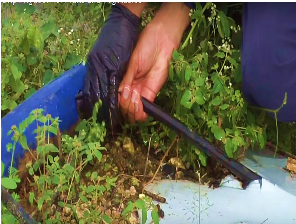
Рисунок 1.20 – переподключение капельной линии к многообразию (манифолду) во время полива
