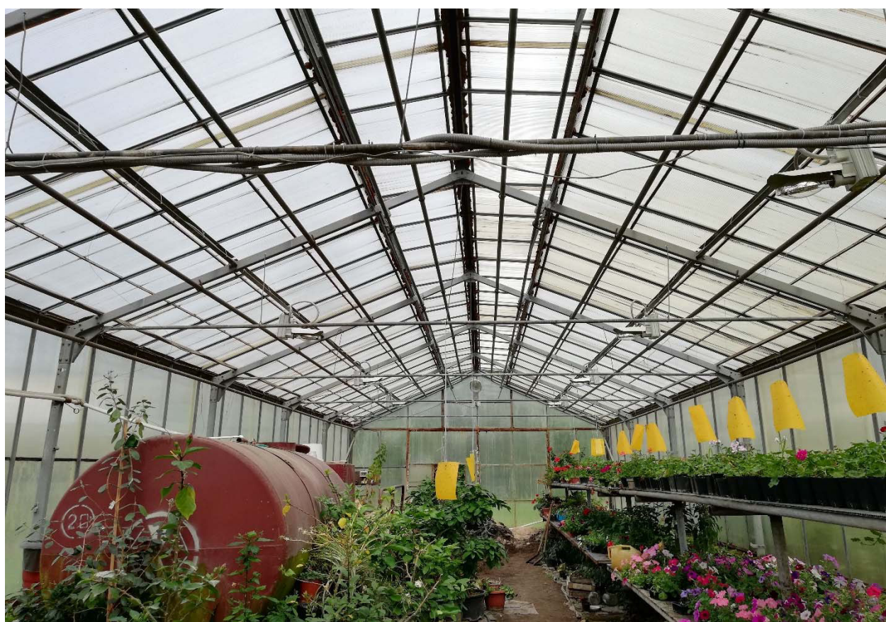
Рисунок 19 - Монтаж системы освещения теплицы №2.
