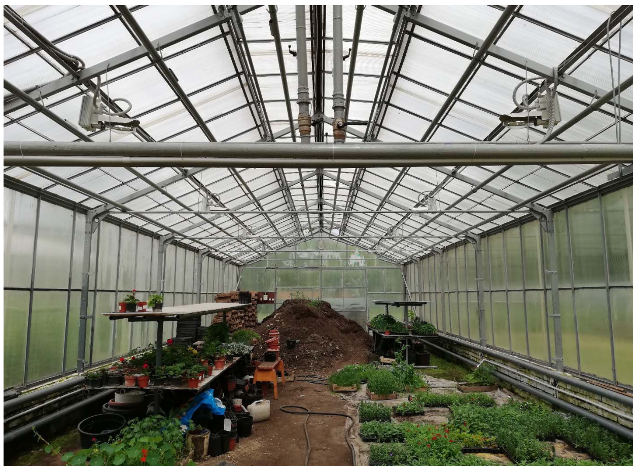
Рисунок 20 - Монтаж системы освещения теплицы №3.
