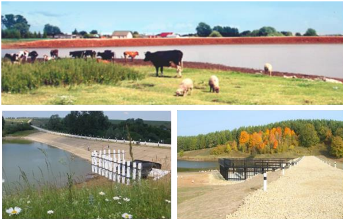
Рис. 3 – Восстановленные гидротехнические сооружения в Республике Татарстан
