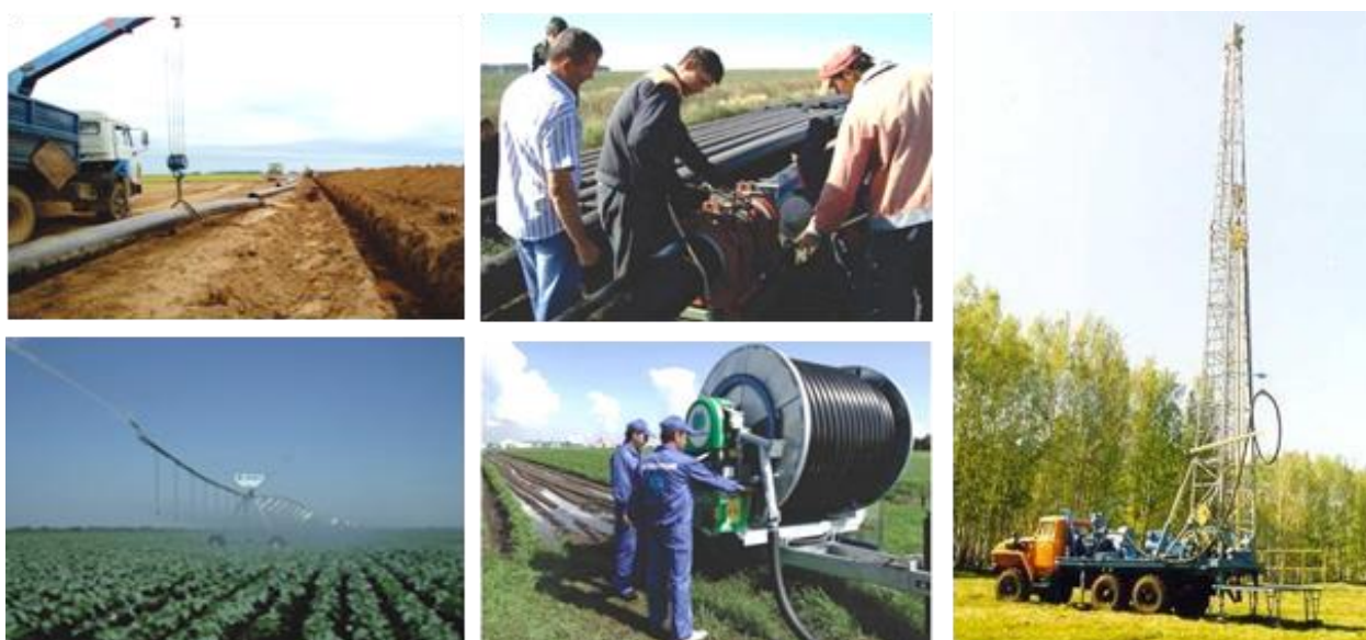
Рис. 2. – Строительство инфраструктурных объектов мелиоративного хозяйства
