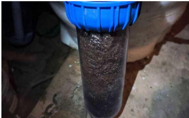
Рисунок – 2.2 Фильтр для очистки биогаза от сероводорода
