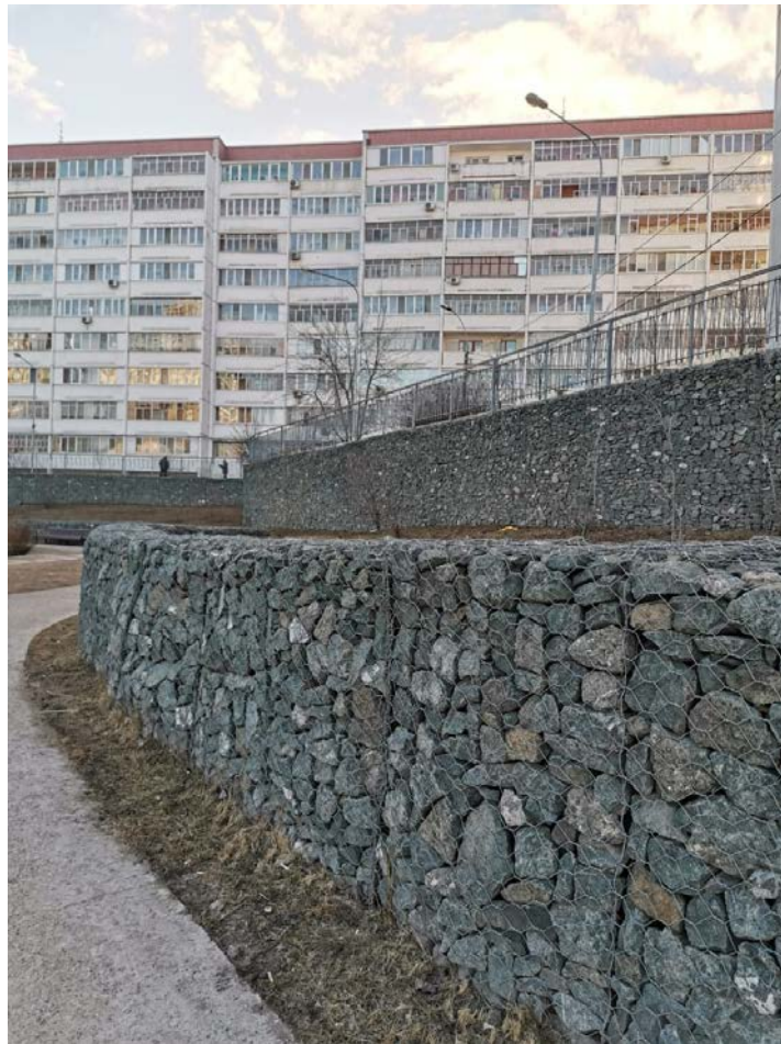
Рис 7 Подпорные стенки, украшенные габионами на территории сквера «Чишмяле»
