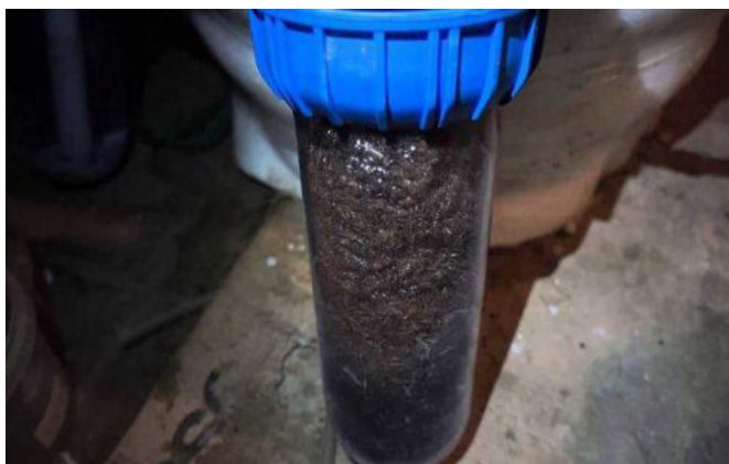
Рисунок – 2.2 Фильтр для очистки биогаза от сероводорода
