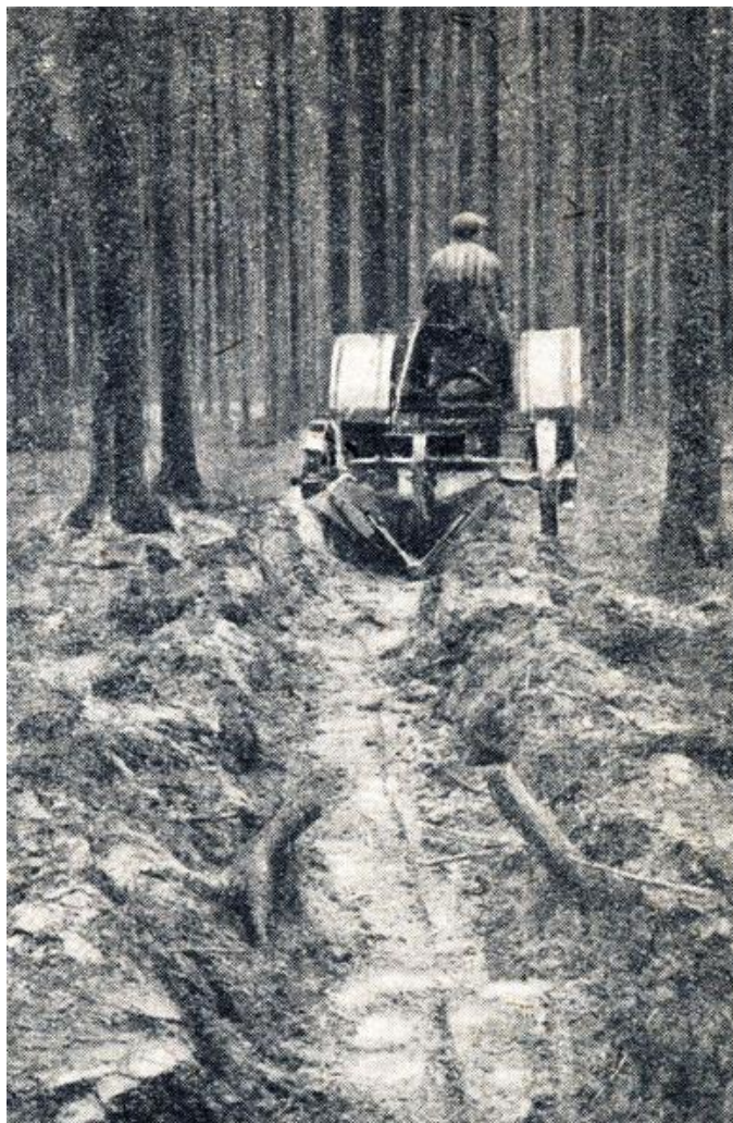
Рис. 10. Двухотвальный тракторный лесной плуг во время работы.
