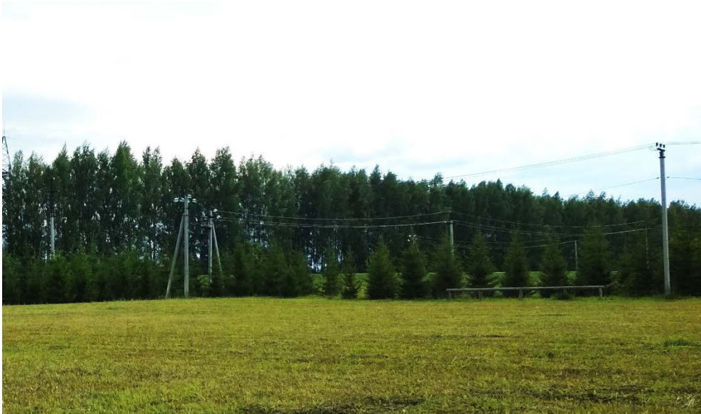
Рис. 7. Фотофиксация инженерных сетей
