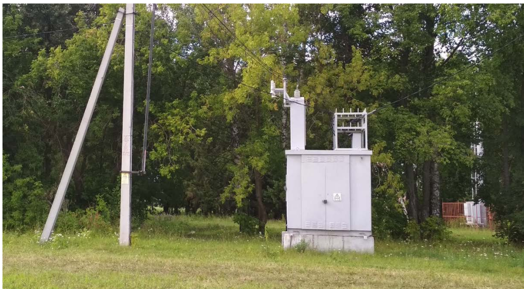
Рис. 5. Фотофиксация трансформаторной будки
