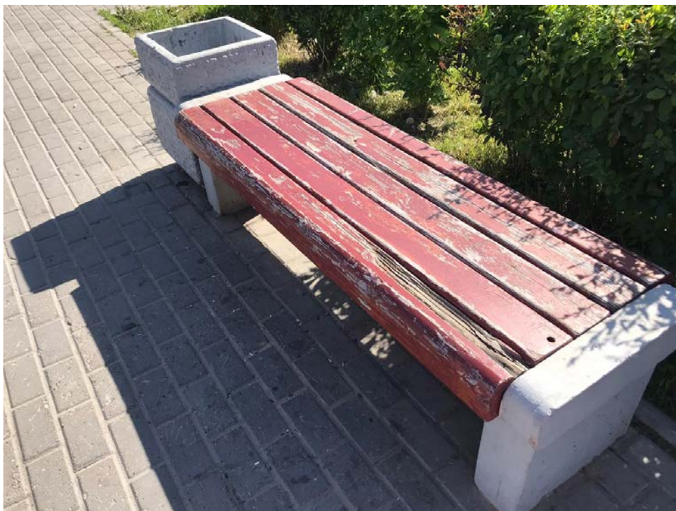
Рис. 17 скамейки которые требуют реставрации
