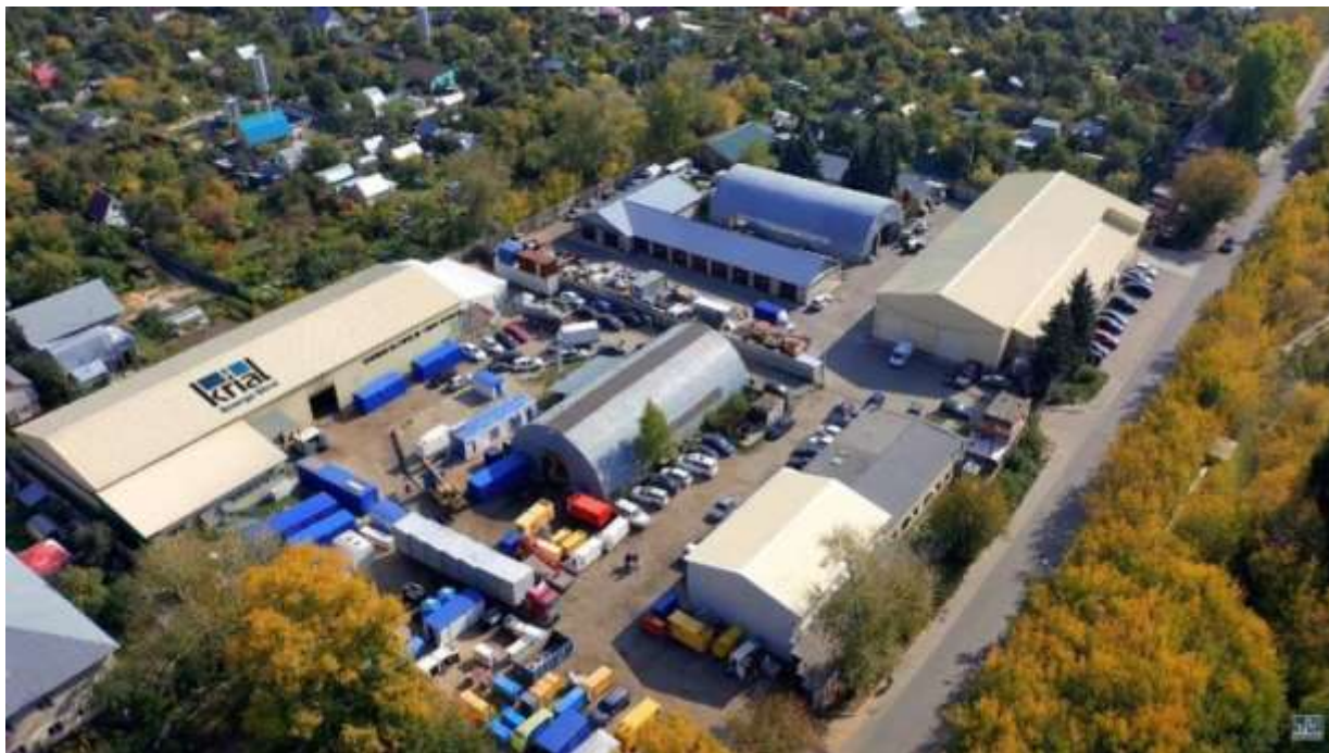
Рис. 1. Территория «Криал Энерго Строй».
