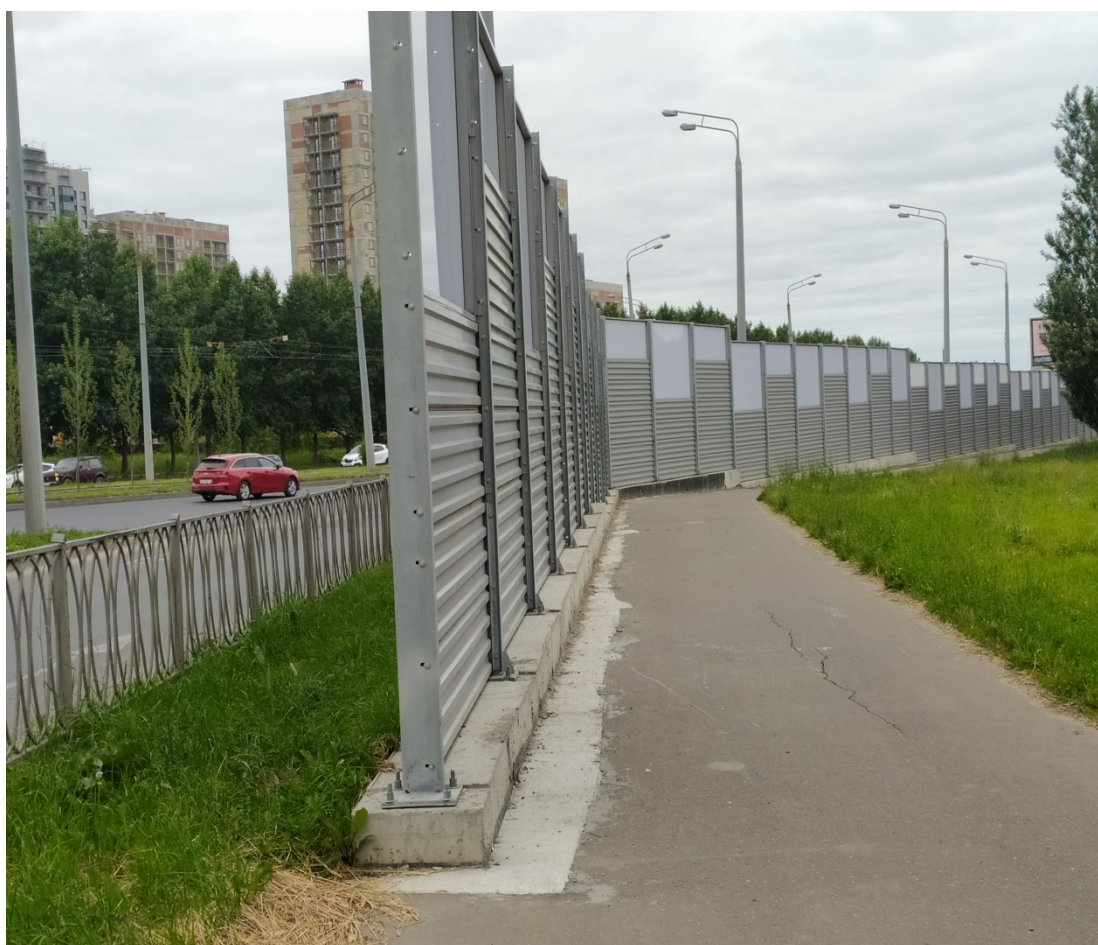
Рис. 3.8 – Шумоизолирующие экраны вдоль Проспекта Победы
