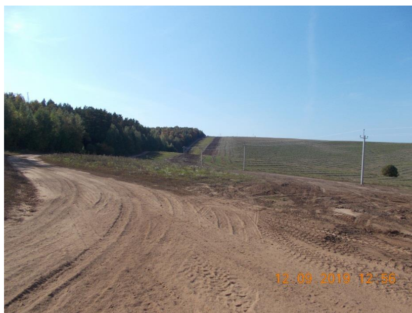
Рисунок 11. Возврат плодородного слоя почвы из отвала
