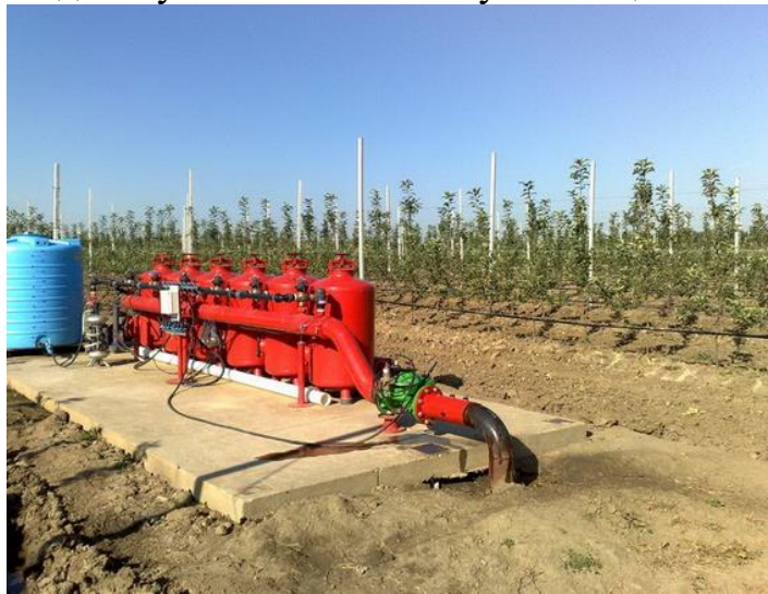
Рисунок 21. Внешний вид насосной станции
