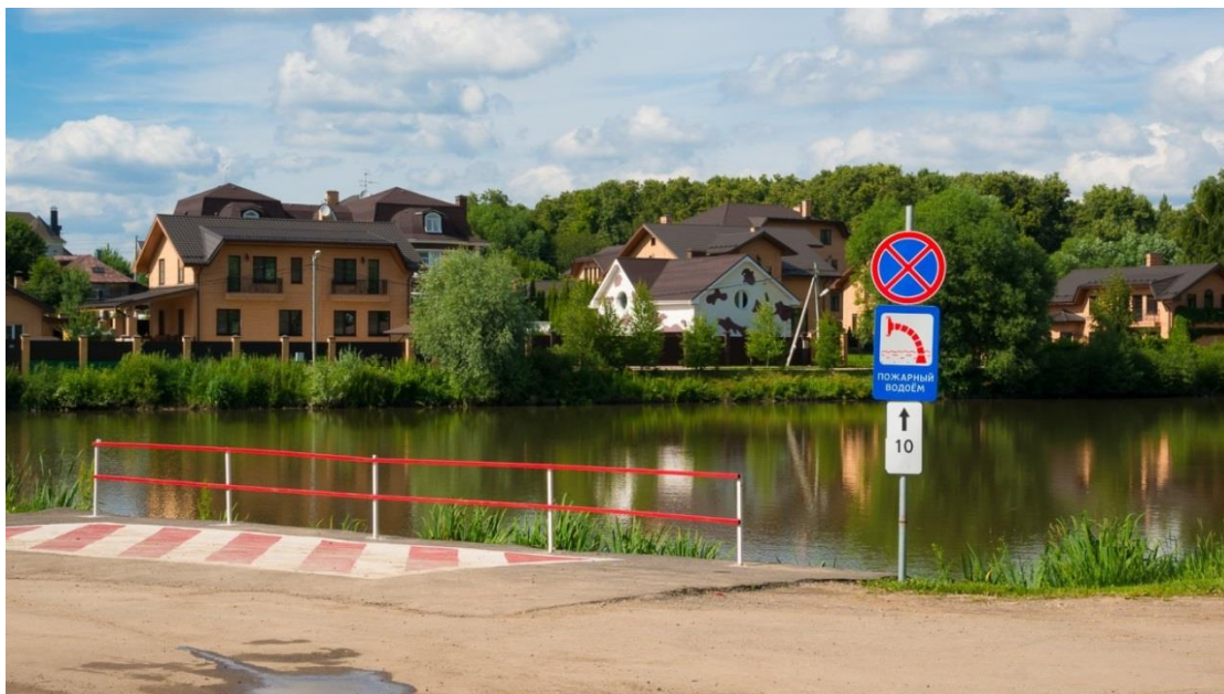
Фото важным 4 – Пожарный водоём в посёлке Руэм
