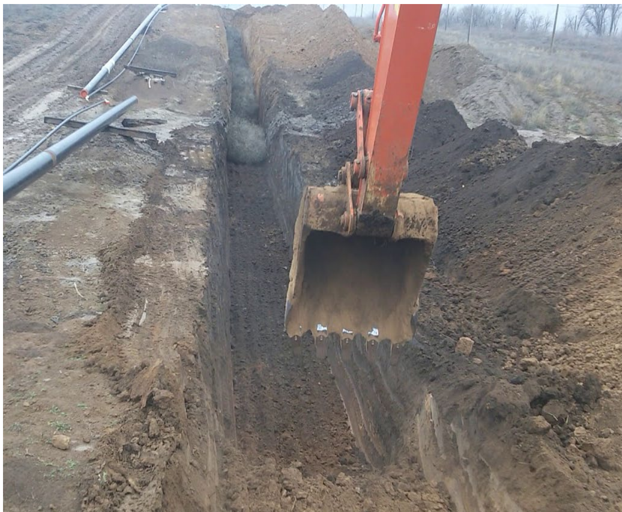
Рисунок – 27 Выкапывание траншеи
