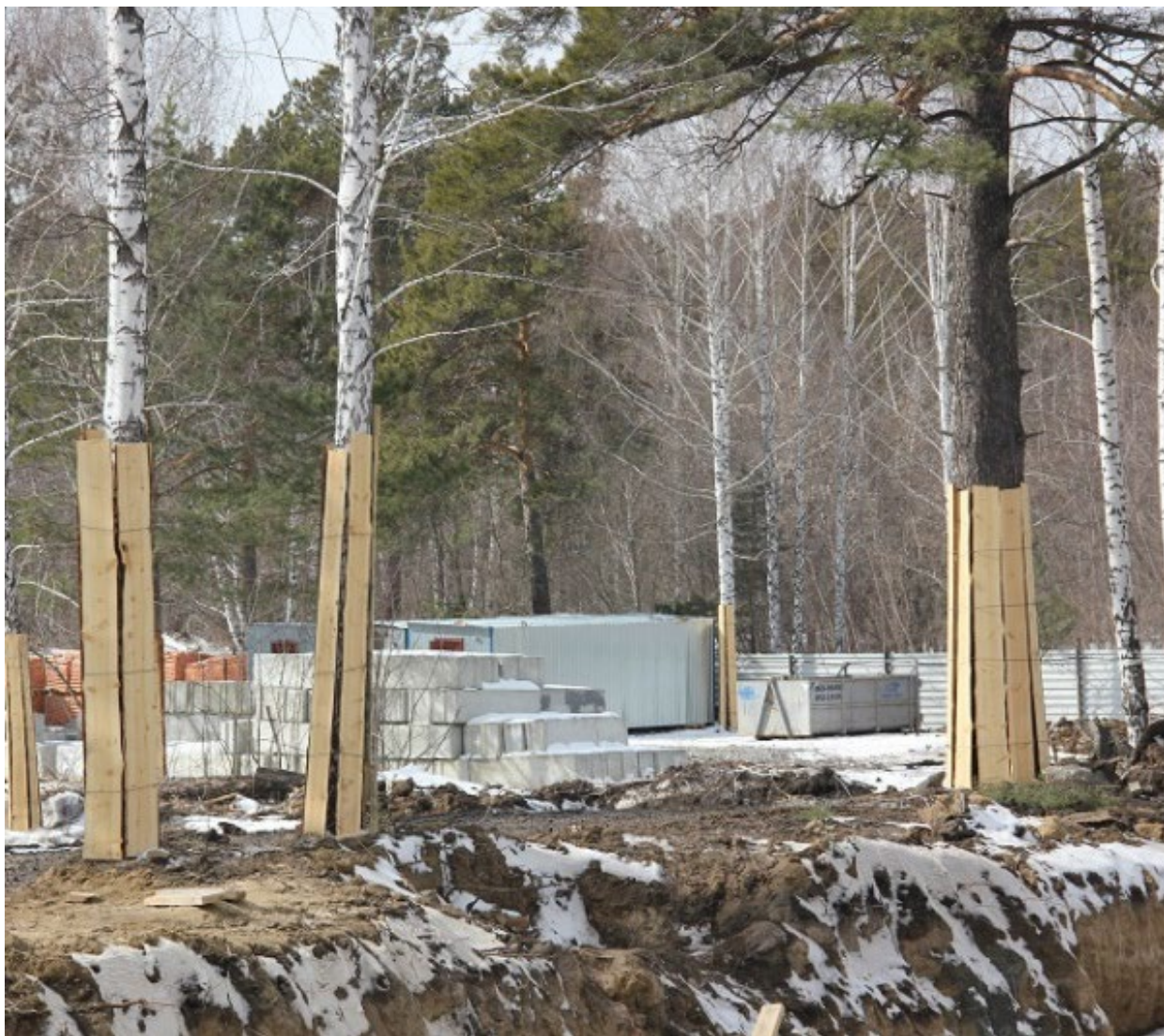
Рисунок – 23 Ограждение деревьев щитами
