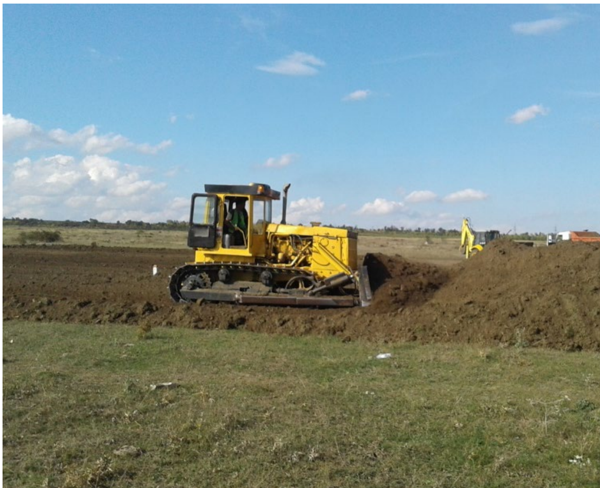
Рисунок – 26 Снятие плодородного слоя почвы
