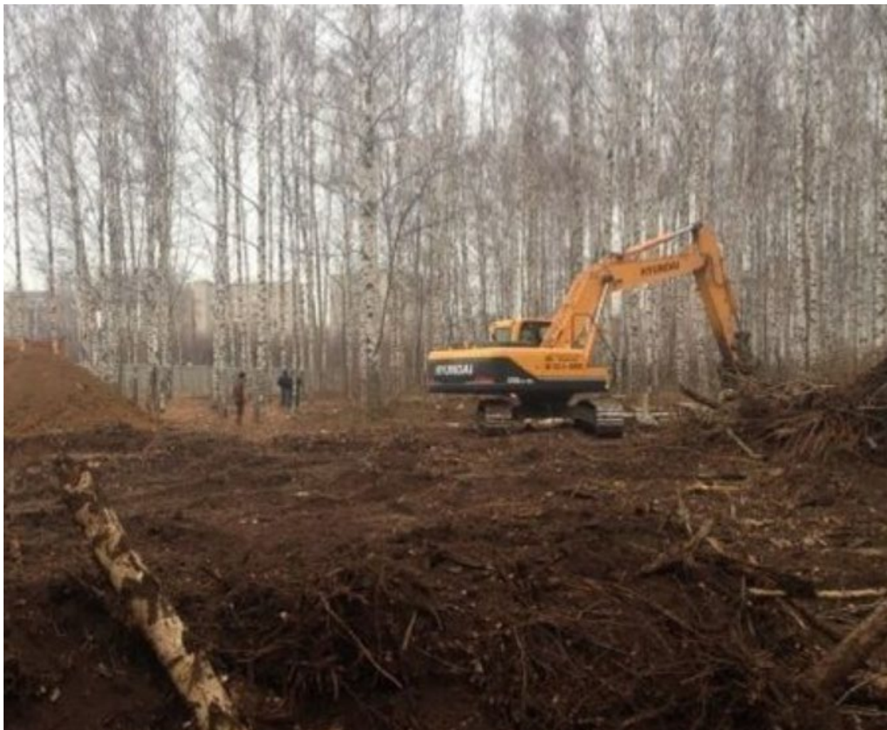
Рисунок – 24 Вырубка деревьев на строительной площадке
