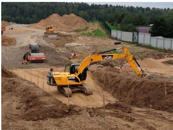
Рис. 3. Вертикальная планировка комплектом машин ( экскаватор, каток, бульдозер )
