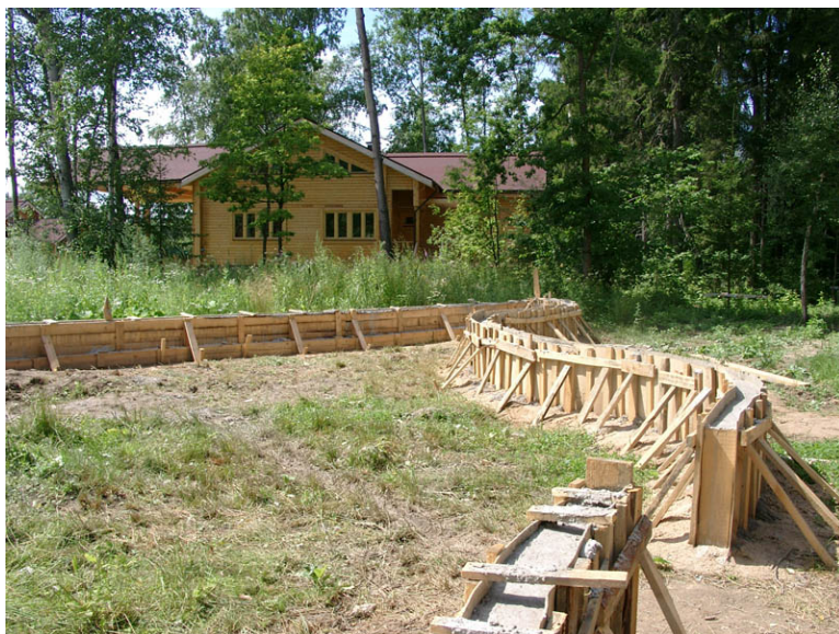
Рис. 17. Устройство подпорной стенки из бетона
