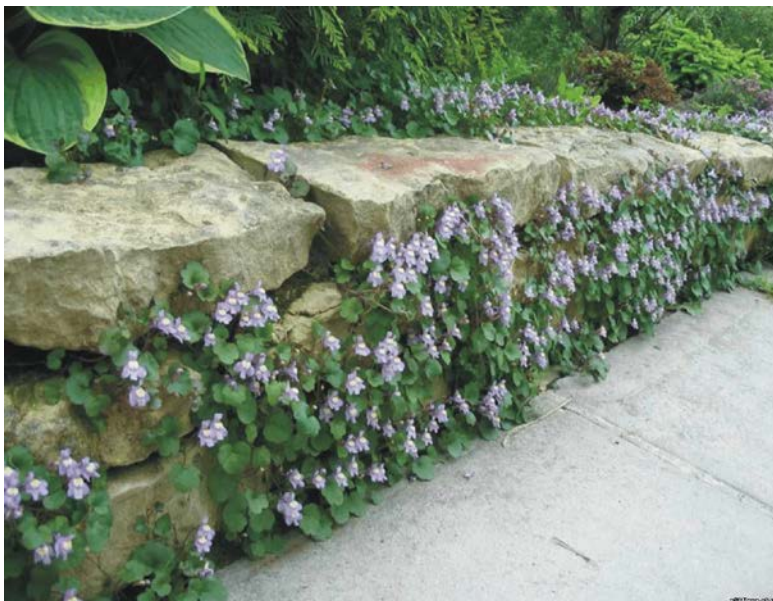
Рис. 16. Подпорная стенка, выполненная путем «сухой» укладки
