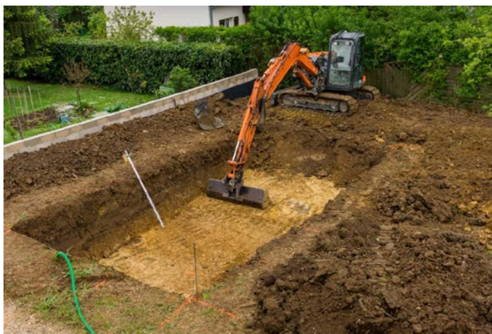
Рис. 2. Вертикальная планировка с применением экскаватора
