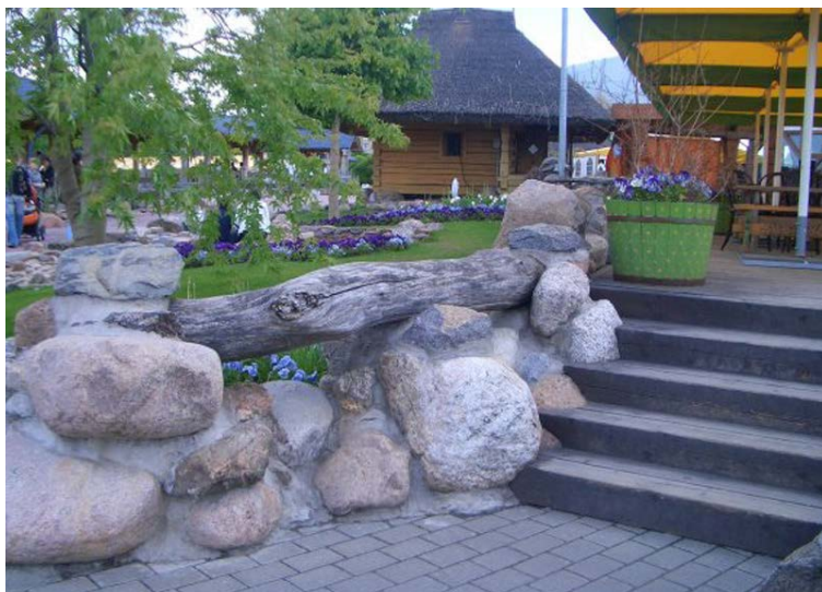
Рис. 18. Декорирование подпорной стенки деревом
