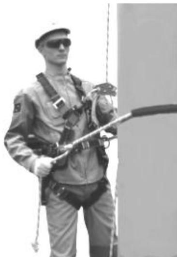
Рисунок 2.1 – Система позиционирования
