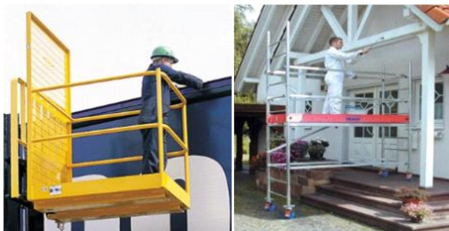
Рисунок 1.2 – Работы на высоте с применением средств подмащивания
