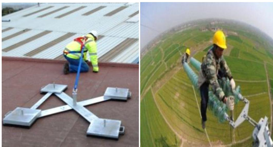
Рисунок 1.3 – Работа без применения средств подмащивания
