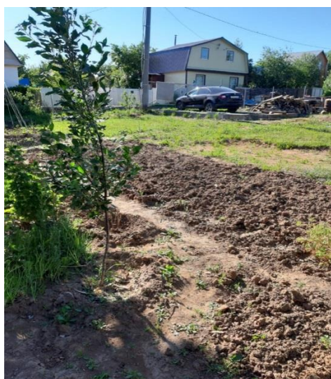
Рис. 6- Подготовка места к будущему бассейну.
