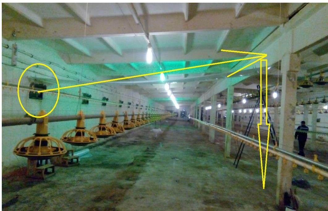
Рис.6- Направление потока воздуха через форточки
