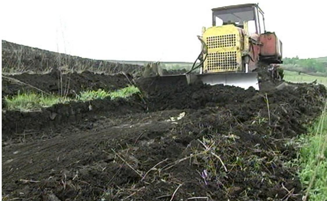
Рисунок 5.3 Процесс террасирования на склонах
