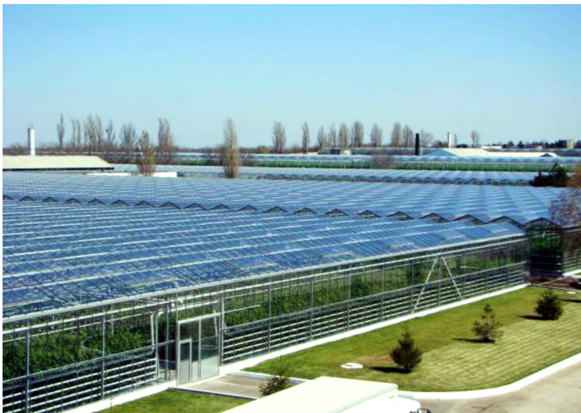
Рис. 15 - Тепличные хозяйства Туймазинского района ООО «КХ «Абсолют»
