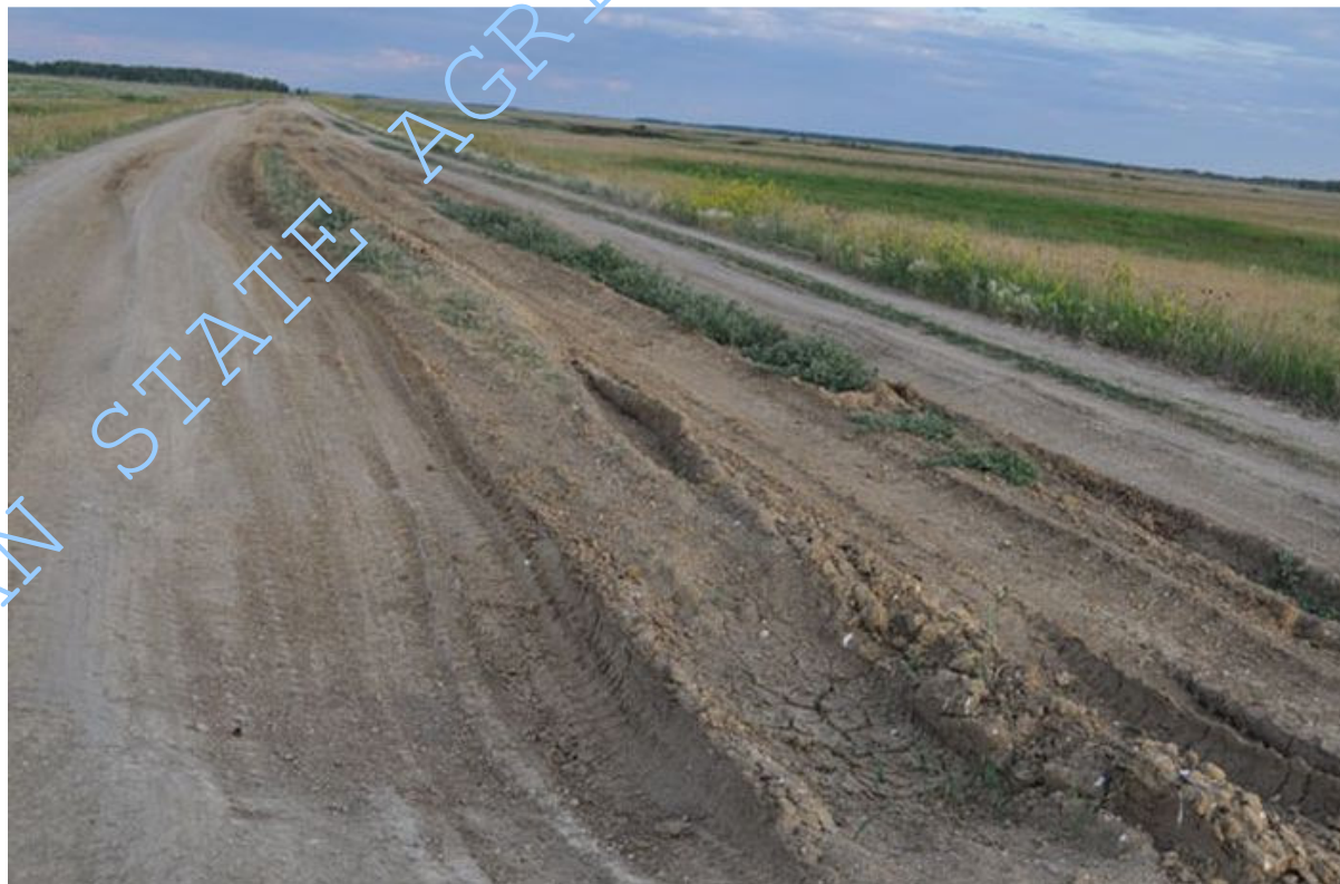
Фото 6. Правильно размещенная полевая дорога временного использования
