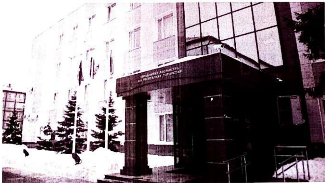
Рис.2 – ул. Авангардная, д.74, здание Росреестра РТ.
